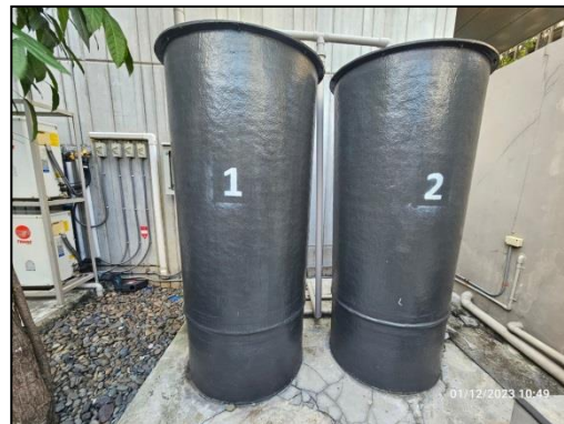
รูปที่ 7 ระบบบำบัดอากาศ เพื่อกำจัดละอองน้ำจากระบบบำบัดน้ำเสีย
