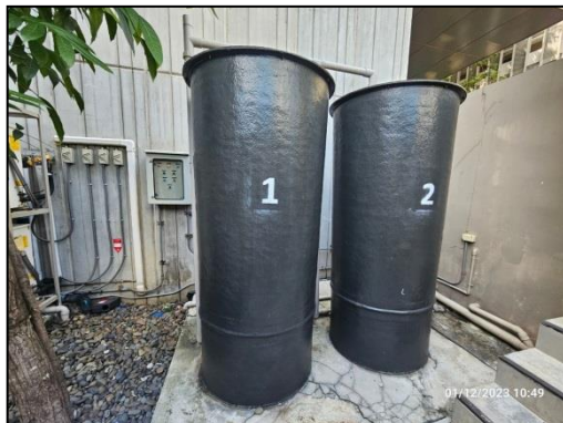
รูปที่ 7 ระบบบำบัดอากาศ เพื่อกำจัดละอองน้ำจากระบบบำบัดน้ำเสีย
