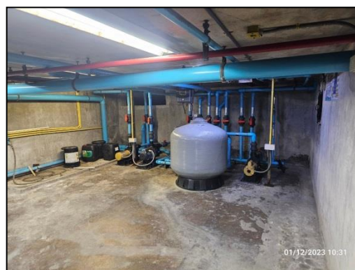
รูปที่ 12 ระบบรับน้ำจากการประปานครหลวงในโครงการ
